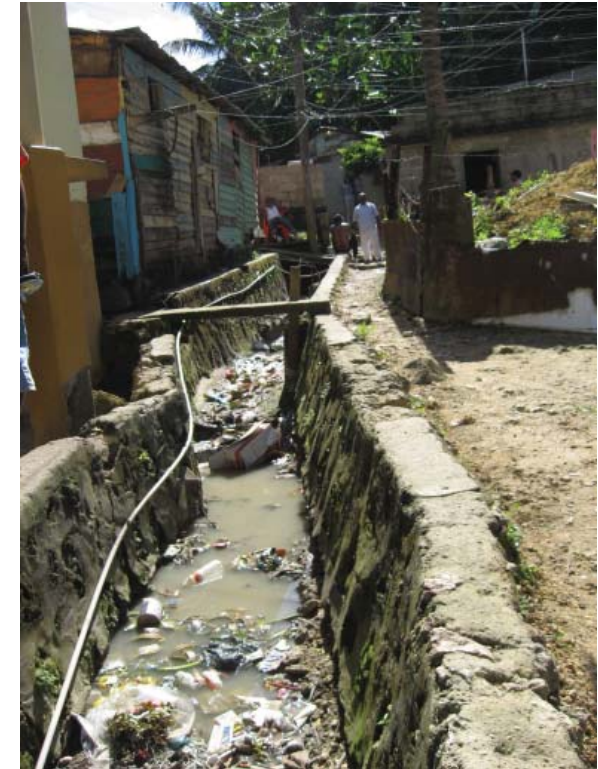
Ilustración 3.17 Una sección destapada de la cañada con nivel bajo de agua.
