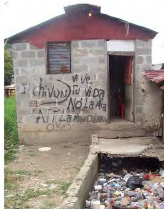
Ilustración 4.10 Las acumulaciones obstruyen la corriente de agua.
