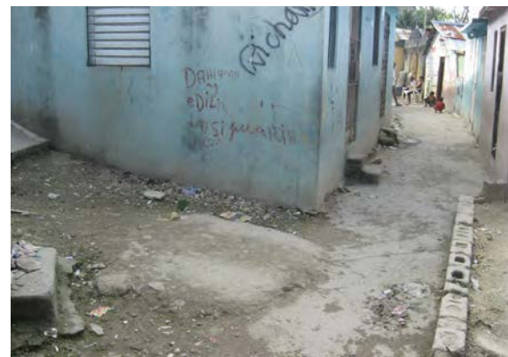
Ilustración 5.25 La zona 19 requiere pavimentación para mejorar el acceso.
