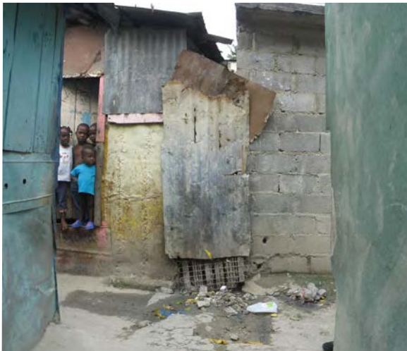
Ilustración 5.17 Las residentes han tratado de resolver el problema de inundación en la Zona 12.
