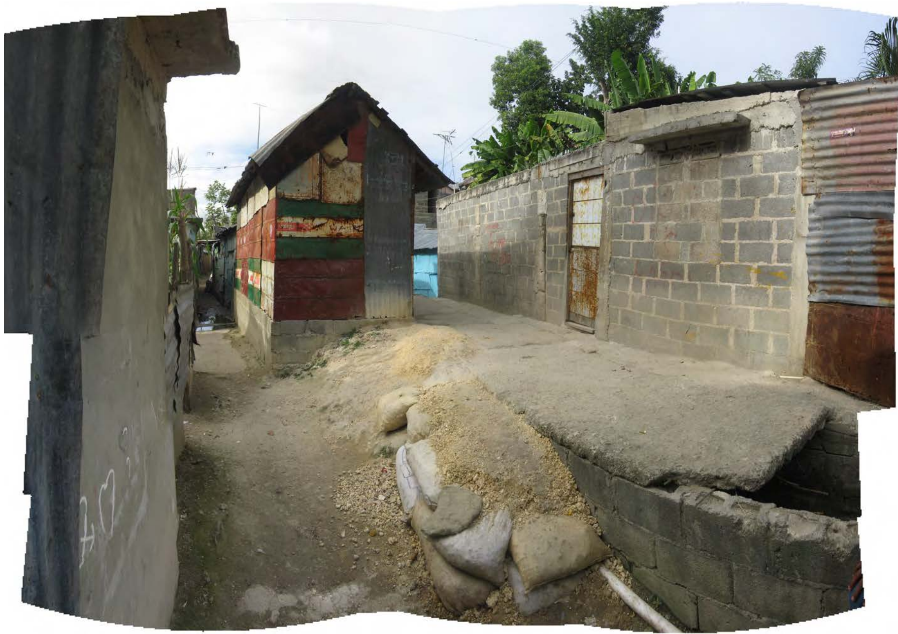
Ilustración 5.19 Los residentes han usado sacos rellenos de tierra para construir una rampa en la Zona 14.
