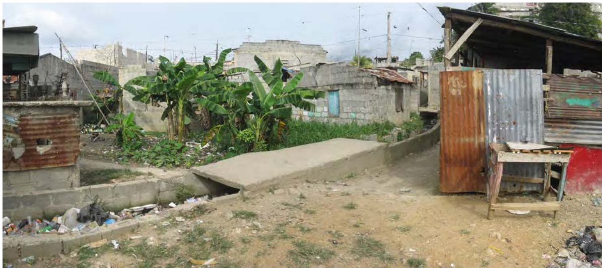
Ilustración 5.12 El puente en la zona 3 requiere una rampa para facilitar el acceso.
