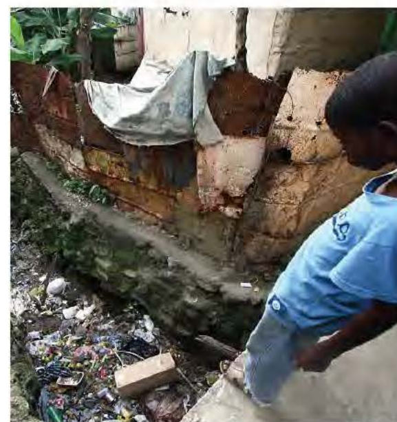
Ilustración 2.7 El flujo del agua en esta sección de la cañada ha sido obstruido por la presencia de desechos sólidos.
