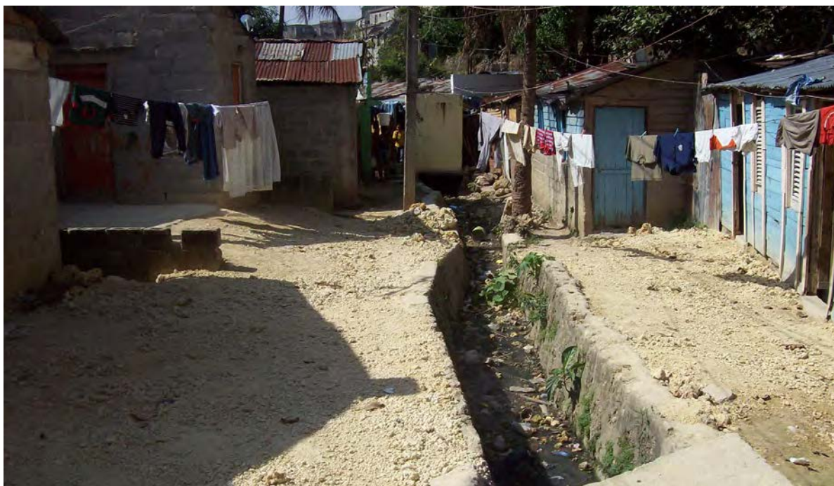
Ilustración 5.30 El sendero en la Zona 21 requiere cobertura de cemento.
