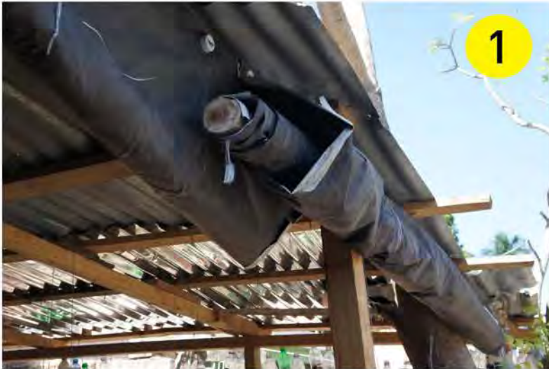
Este sistema obstruye la lluvia, pero queda enrollado cuando no se necesita. This system keeps rain from entering, but it stays rolled up when it is not needed.
