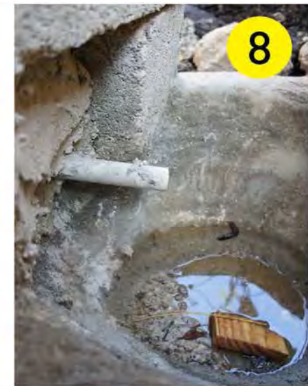
Este tubo junta el abono líquido de las cajas. This tube gathers liquid compost from the bins.
