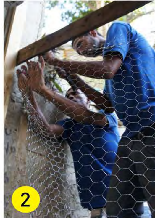
Encerramos el lado del sur con maya ciclónica. We enclosed the south side with chicken wire.
