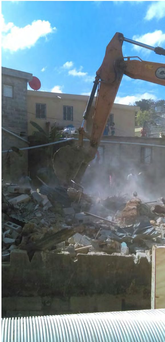
Ilustración 4.13 Demolición de viviendas por trabajadores de CAASD en curso en 2017.
