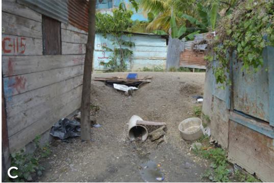
C Tuberías transversales realizadas por los vecinos para evitar inundaciones. Transversal pipes installed by residents to address flooding.
