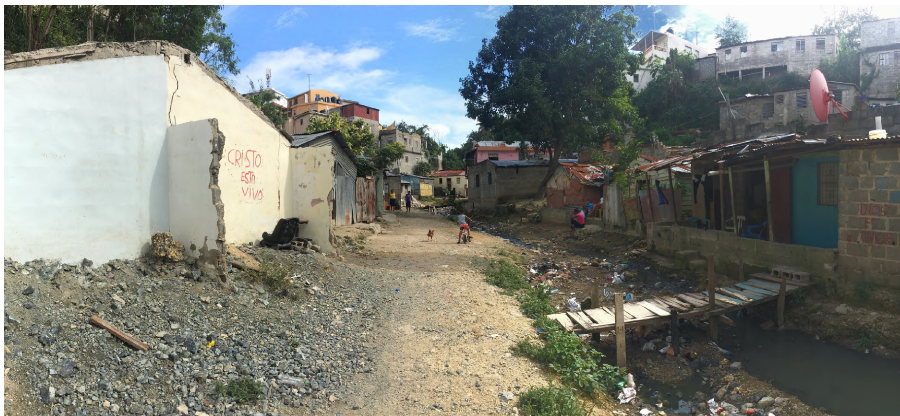
Ilustración 3.1 La sección superior de la cañada no se había completado en 2018, lo que llevó a los residentes a construir puentes improvisados.
