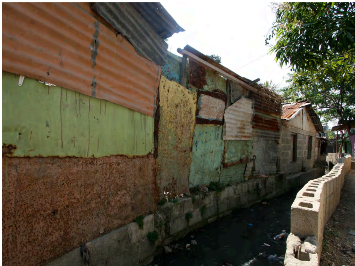
Ilustración 5.12 El mejoramiento de la cañada era una narración central en las historias de los residentes. Las casas se construyeron con hojas de zinc
