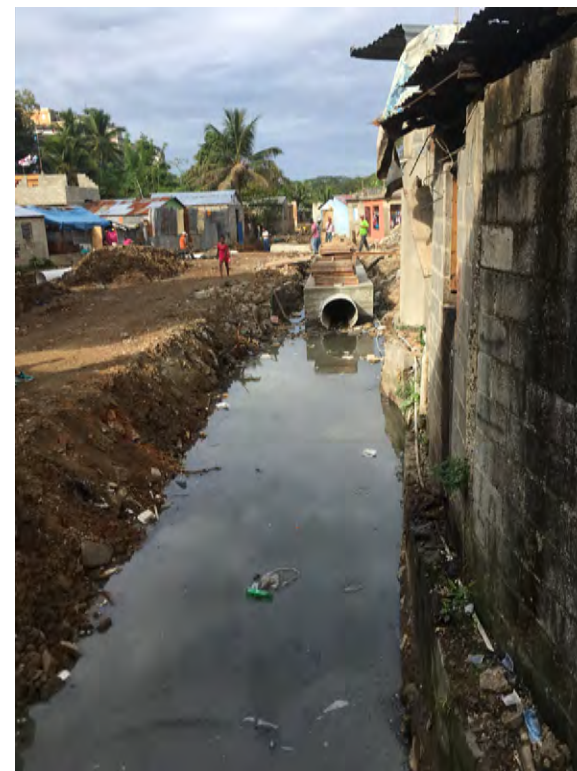
Ilustración 1.8 Construcción del canal de drenaje
