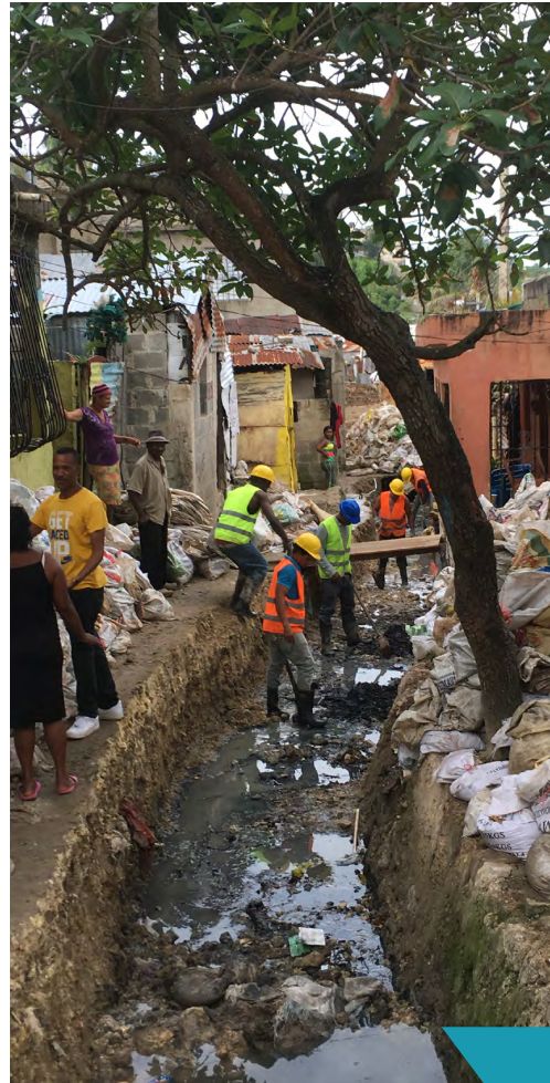
El proyecto de CAASD transformando la infraestructura de la cañada a través de quitar, añadir tubería, poner hormigón en la parte inferior, y cubrir el agua.
