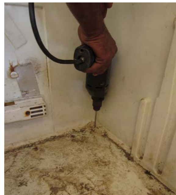
Ilustración 5.17 Abriendo agujeros de drenaje en un cajón de nevera
