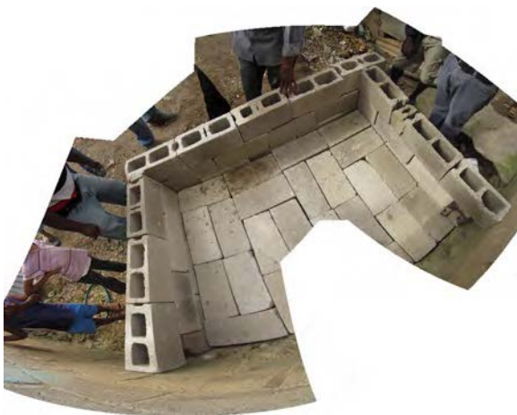
Ilustración 5.8 Construyendo la base de una caja de bloques.
