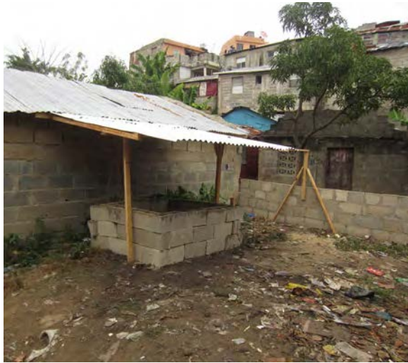
Ilustración 5.12 El sitio Los Cinco Corazones durante la construcción
