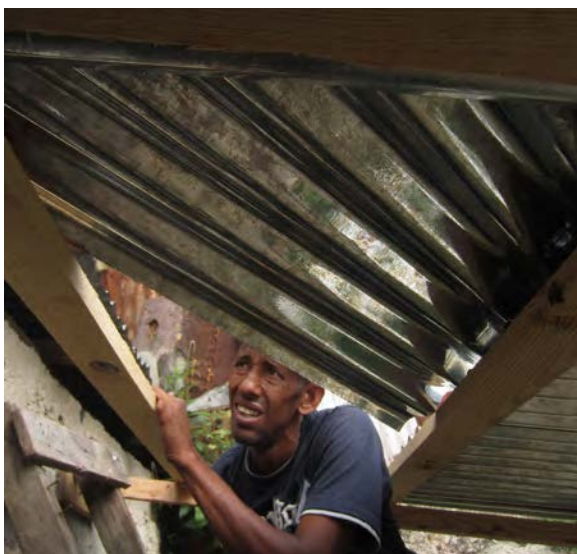
Ilustración 5.11 El proceso de construcción del techo de los sitios de lombricultura
