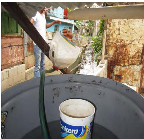
Ilustración 6.5 El sistema de canalización de agua de lluvia construido con materiales reciclados.
