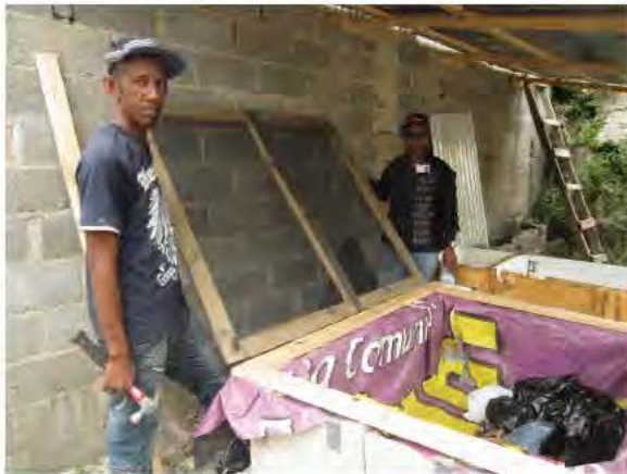
Ilustración 5.10 Instalando el marco de la tapa en los recipientes de lombricultura.
