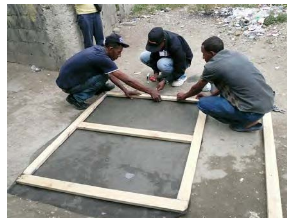
Ilustración 5.9 Construyendo el marco de la tapa de los recipientes de lombricultura.
