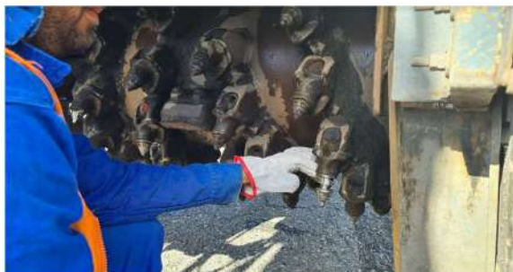
Figura 7. Substituição das pontas de desgaste (Fonte Próprio Autor).
