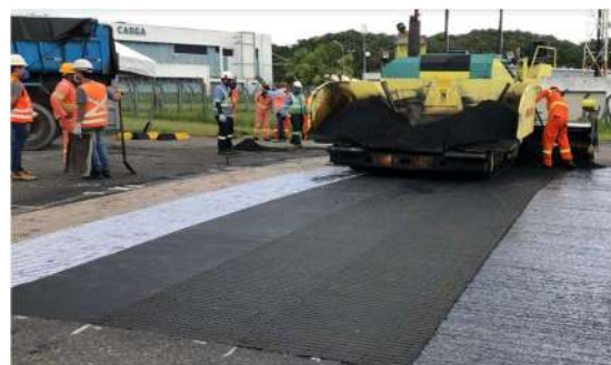
Figura 3 - Instalação dos geossintéticos no Aeroporto (Fonte Próprio Autor).
