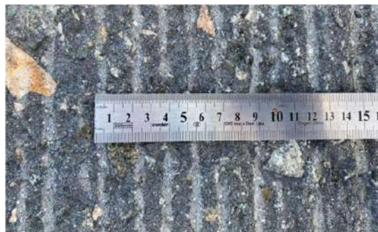
Figura 2. Textura e espessura dos sulcos após a fresagem da camada de revestimento inicial (Fonte Próprio Autor).
