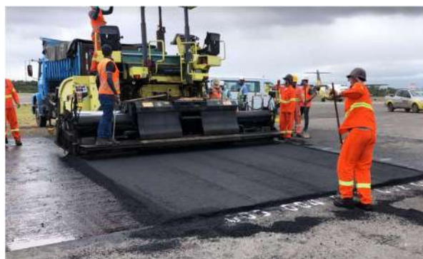
Figura 5. Seção teste em construção no Aeroporto de Salvador (Fonte Próprio Autor).
