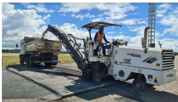
Figura 8. Processo de fresagem e coletado do material G-RAP (Fonte Próprio Autor)
